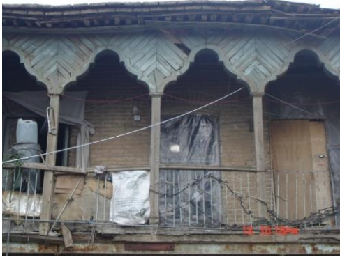
الشكل 3: استعمال الخشب لعمل الأعمدة والزخارف (المصدر: الباحثان)
